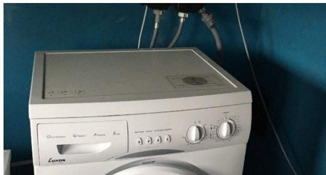
Waschmaschinenanschluß im Keller
